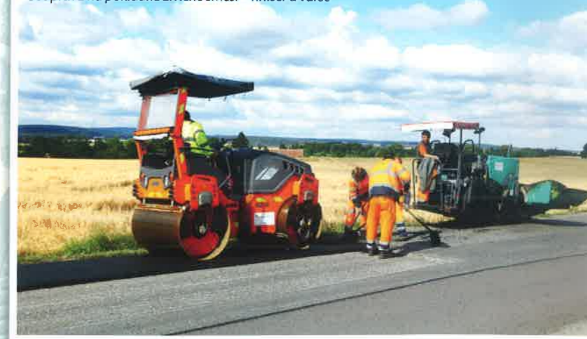
Souprava na pokládku živичné směsi – finišer a váleček
