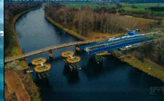
Nasouvání mostní konstrukce
