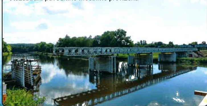
Rozebírání původního mostního provizoria
