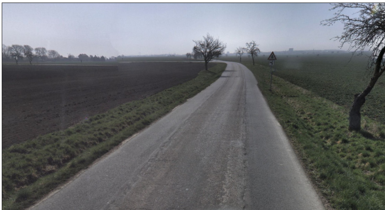
III/322 35 Medlešice – Dřenice – pouze krajnice
